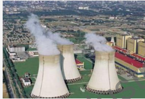
Cooling water 冷却用水
